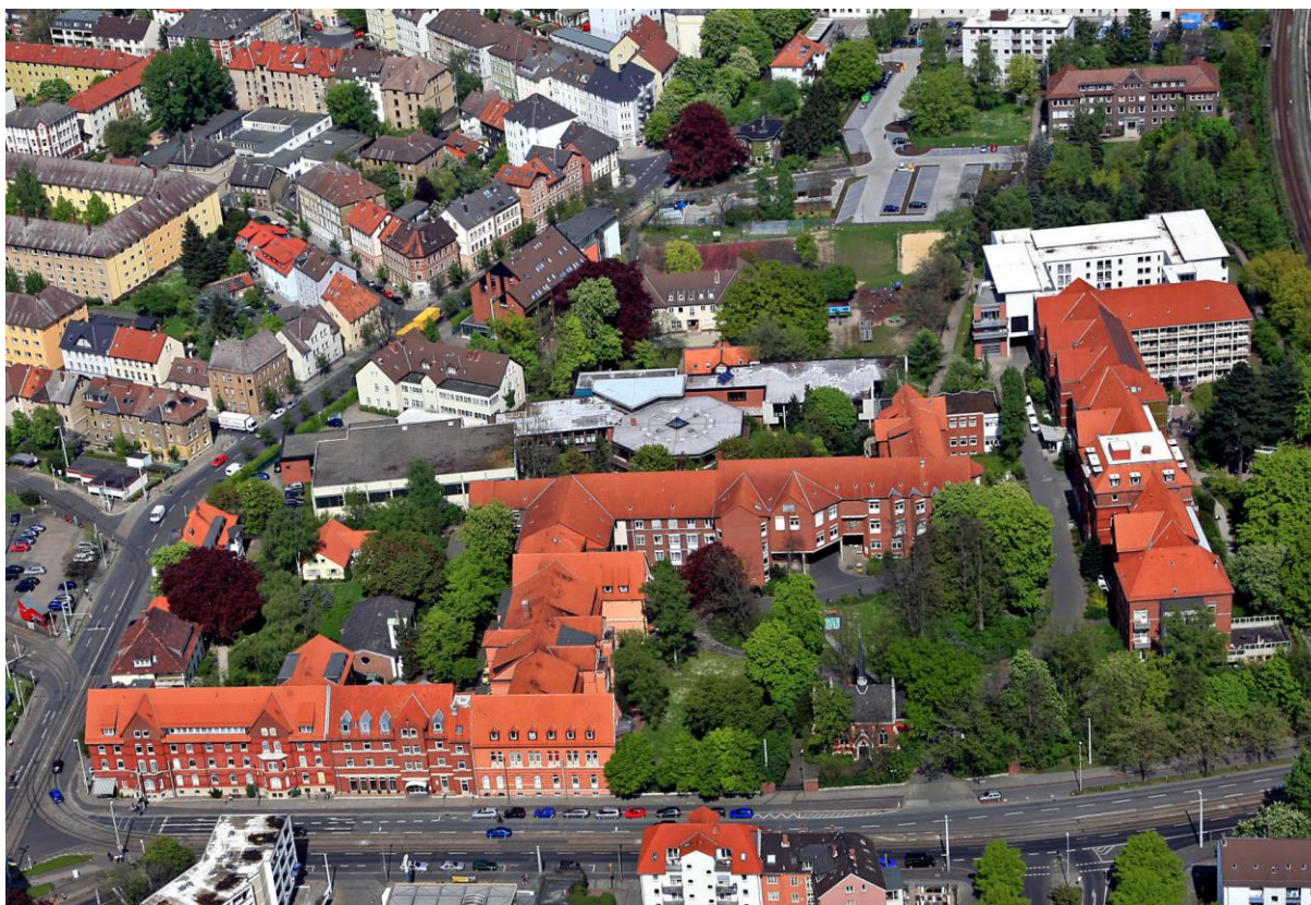
Krankenhaus Marienstift gGmbH in der Luftansicht
